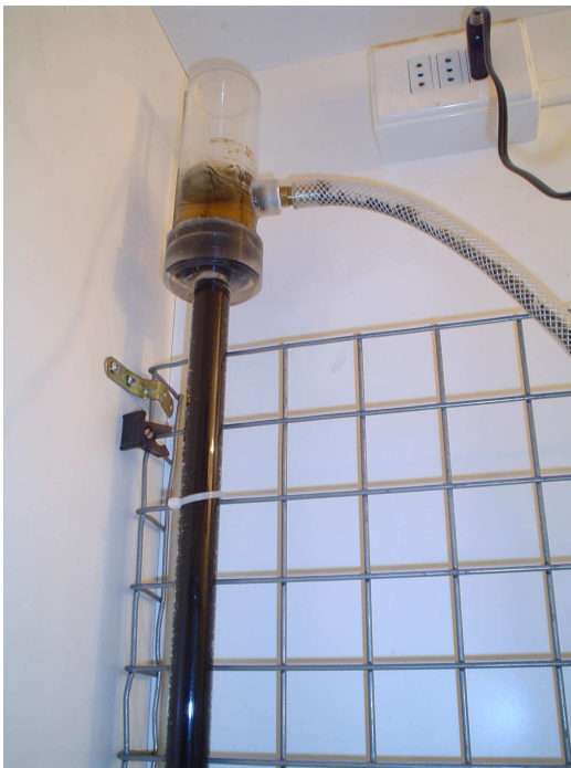
Figura 9.5 Aquí se puede observar la copa del reactor, por donde sale el efluente después del contacto con el lodo anaerobio, el efluente entra luego al recipiente de recirculación, esto ayuda a la dilución del RIL.
