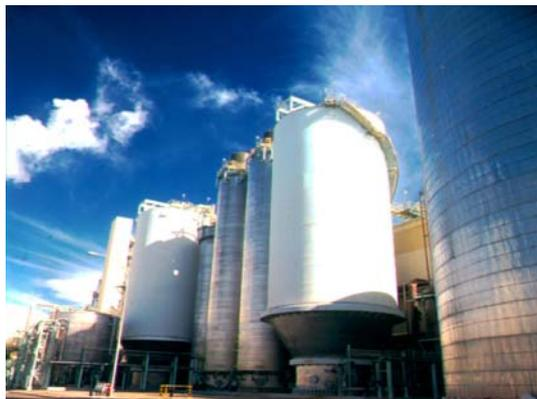
**Figura 6.** Torres de deslignificación y blanqueo en industria de celulosa.
