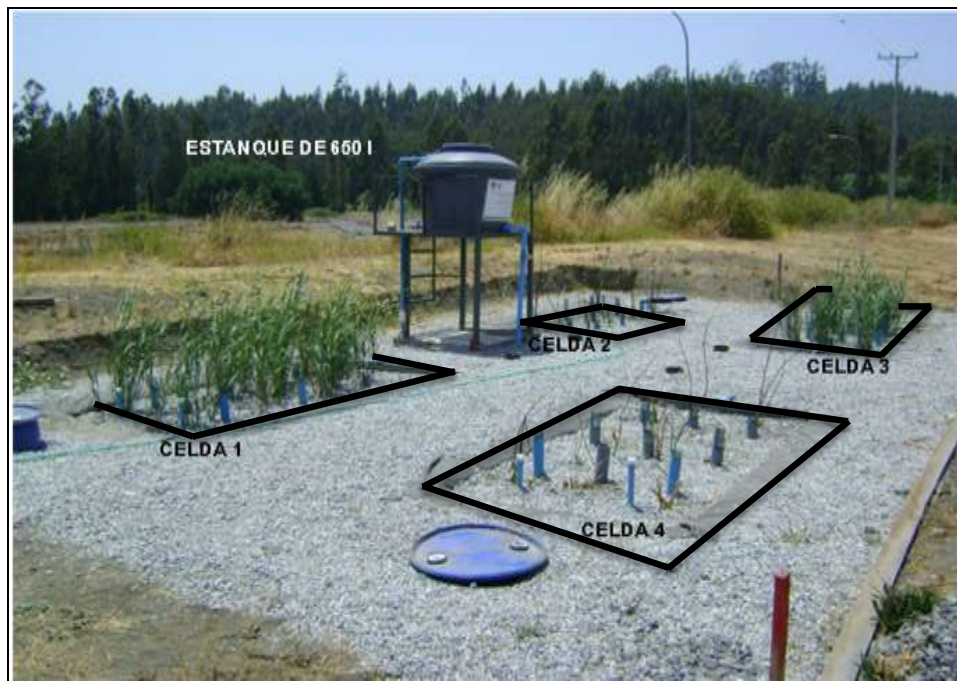
Figura 7. Distribución de las celdas en la Planta piloto de HFSS.
