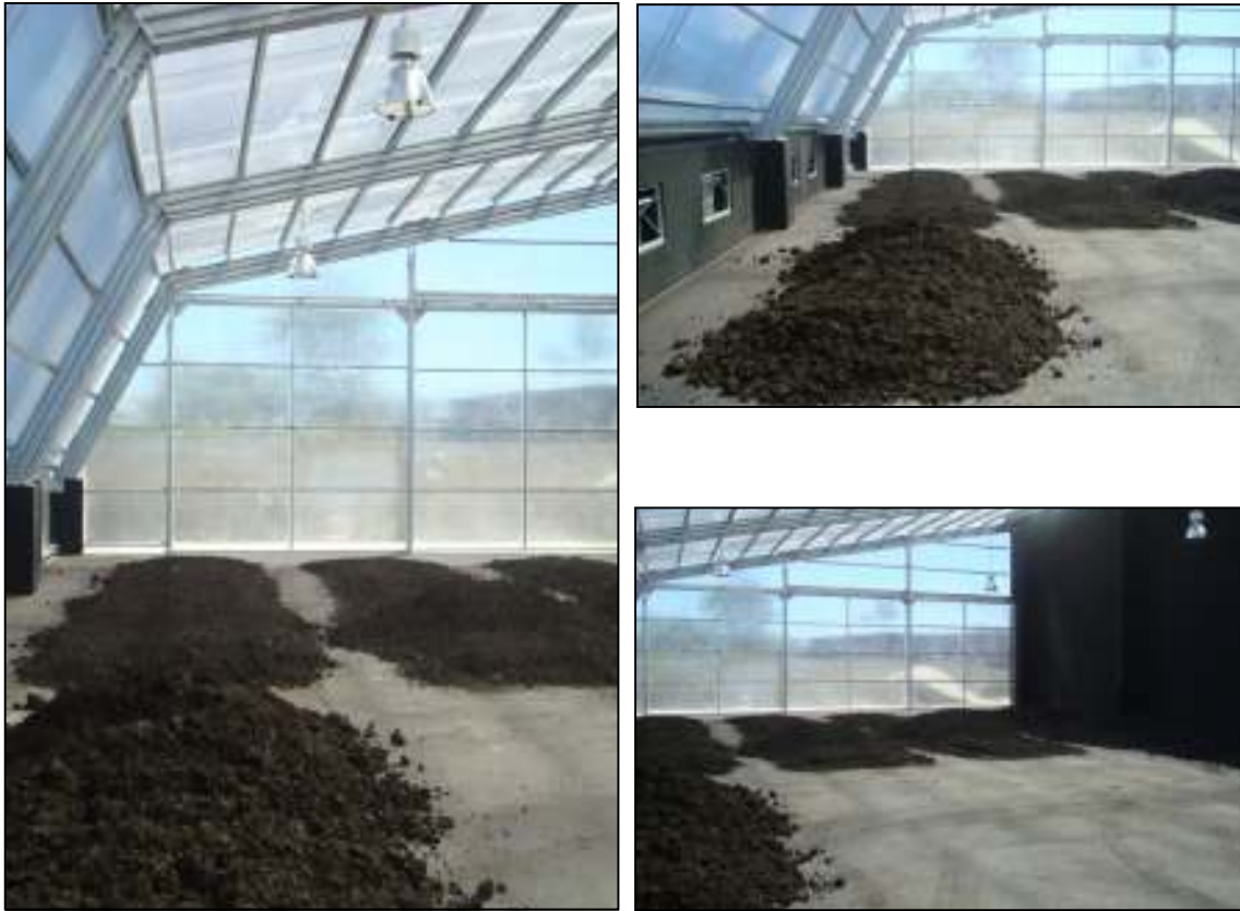
Figura 29. Vistas de galpón de secado climatizado de lodos (ESSBIO S.A.).
