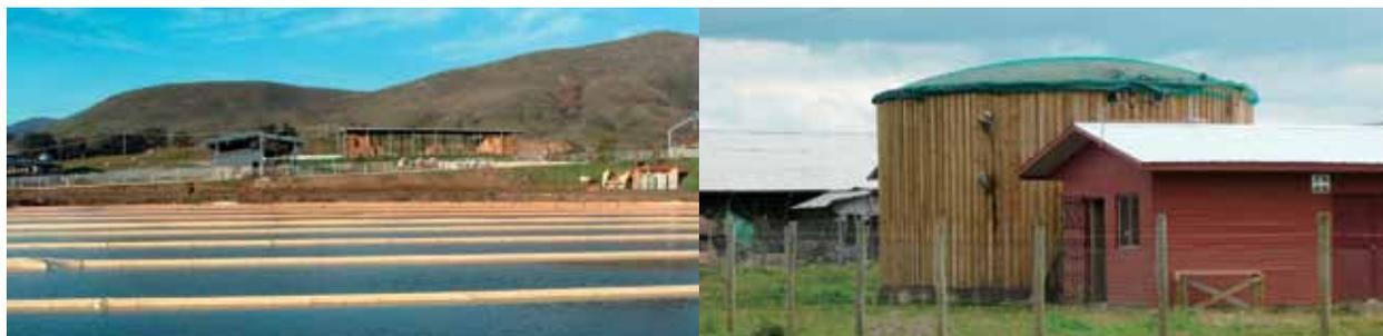
**Figura 6.** Tratamiento para purines. a) Laguna anaerobia Cal Poly. California, USA, b) Biodigestor anaerobio SEPADE. Bio Bio, Chile
